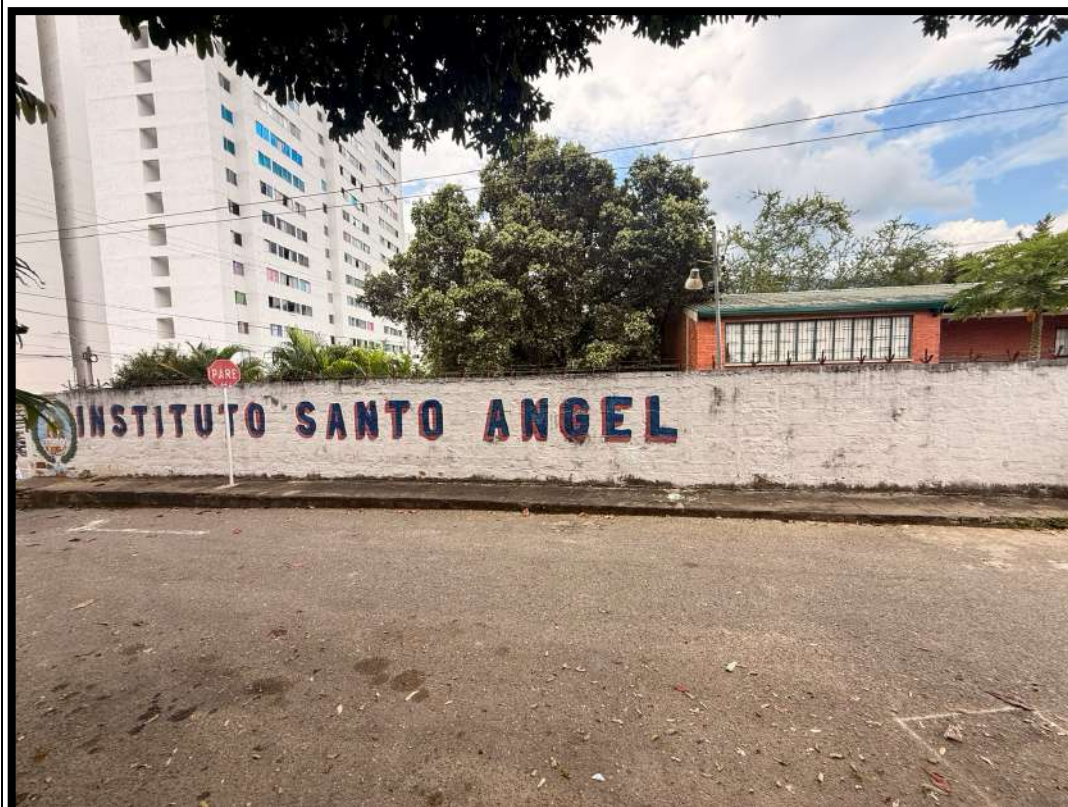
Figura 1. Vista frontal y de contexto del muro exterior del Instituto Santo Ángel.
