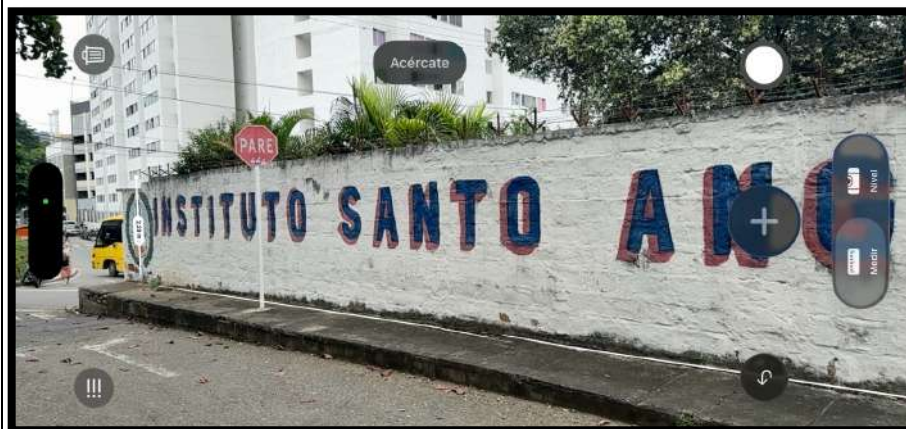
Figura 3. Registro digital de la altura del muro: 2,29 m.
